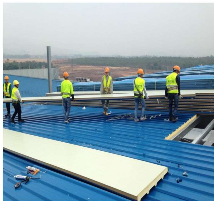
HÌNH ẢNH THI CÔNG LỘP TÔN SOME PICTURES OF THE ROOF PANEL INSTALLATION
