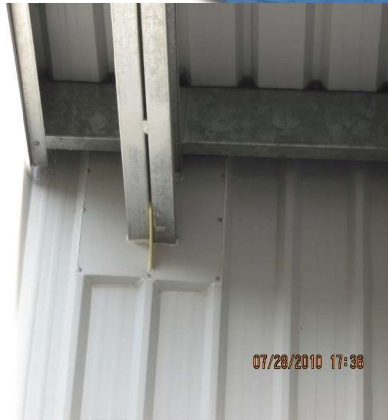
MỘT SỐ HÌNH ẢNH THI CÔNG KE DIỀM SOME PICTURE OF FLASHING INSTALLATION
