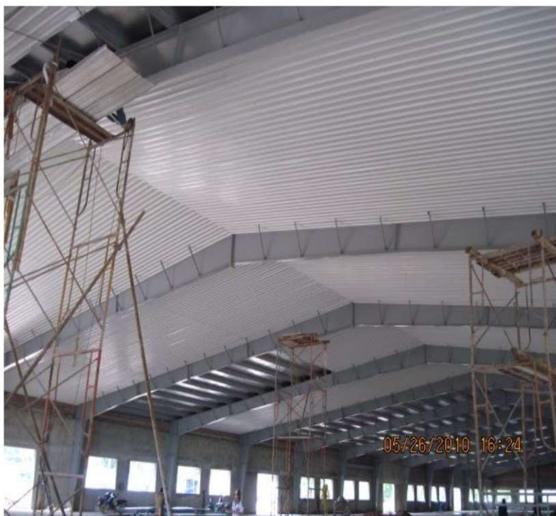
HÌNH ẢNH THI CÔNG LỘP TÔN TRẦN (BÊN TRONG LÀ LỚP CÁCH NHIỆT, TRÊN CÙNG LÀ LỚP TÔN MÁI) SOME PICTURES OF THE CEILING PANEL INSTALLATION (INSULATION INSIDE, ROOF PANEL ABOVE)
