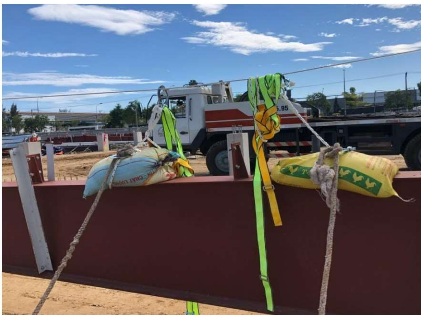
CÔNG TÁC KIỂM TRA CHỊU TẢI CỦA DÂY CỨU SINH VÀ LƯỚI AN TOÀN / PICTURE OF LIFE LINE, SAFETY NETS CHECKING
