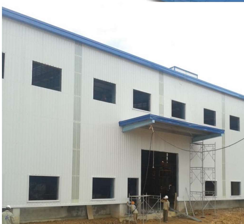
MỘT SỐ HÌNH ẢNH THI CÔNG TÔN THÙNG SOME PICTURES OF WALL PANEL INSTALLATION
