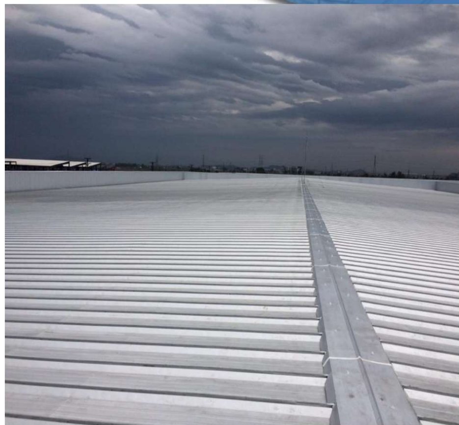
MỘT SỐ HÌNH ẢNH THI CÔNG KE DIỀM SOME PICTURE OF FLASHING INSTALLATION
