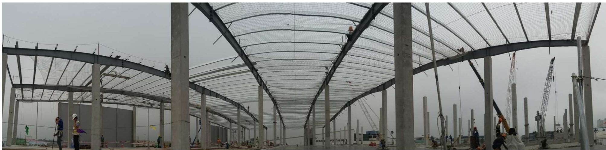
MỘT SỐ HÌNH ẢNH VỀ LẮP DỰNG / SOME PICTURES OF THE ERECTION
