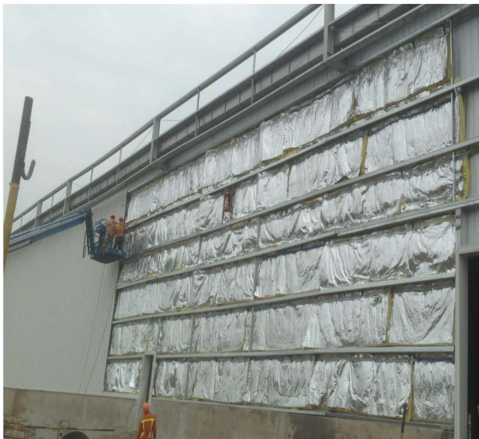
MỘT SỐ HÌNH ẢNH THI CÔNG TÔN THÙNG SOME PICTURES OF WALL PANEL INSTALLATION
