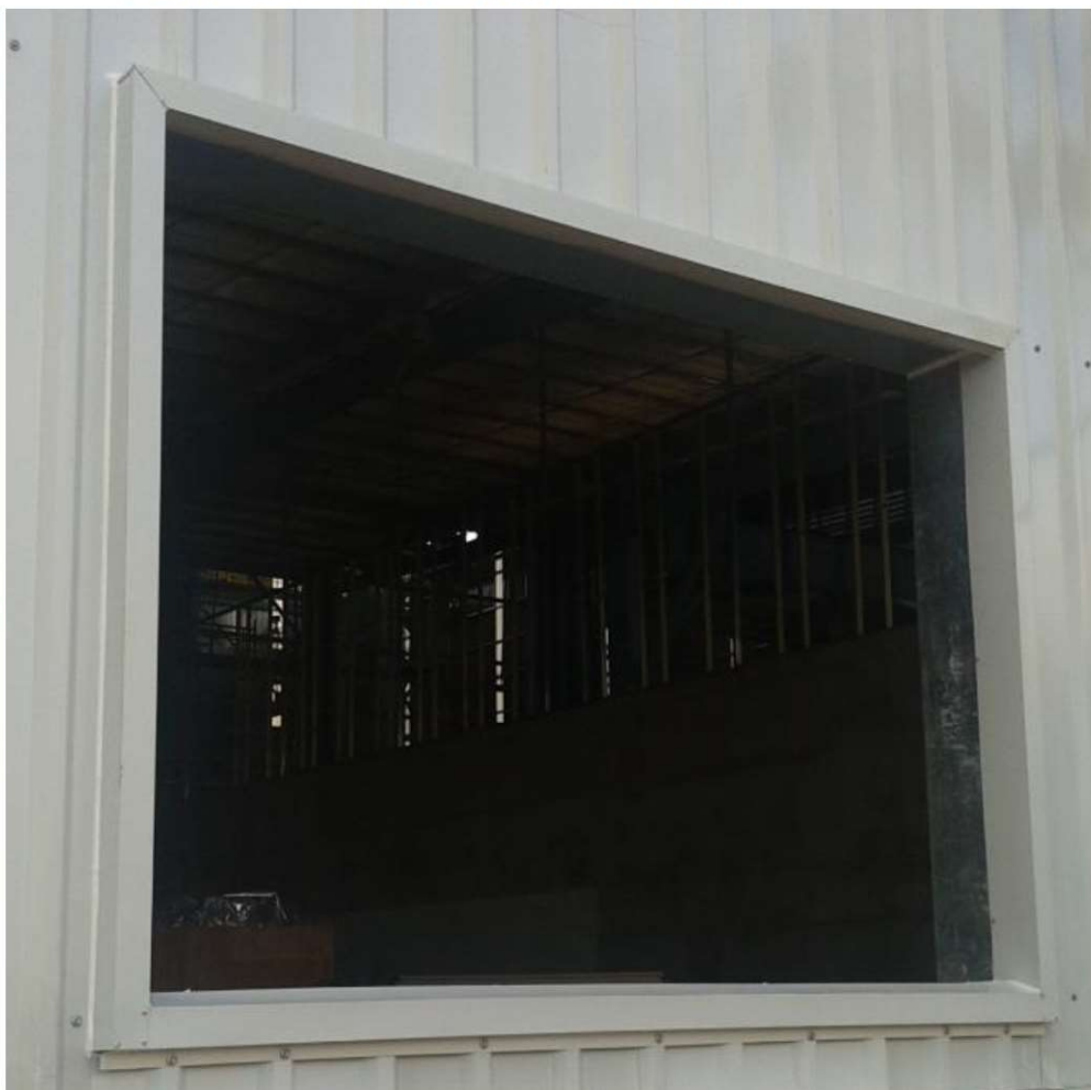
MỘT SỐ HÌNH ẢNH THI CÔNG KE DIỀM PICTURE OF FLASHING INSTALLATION
